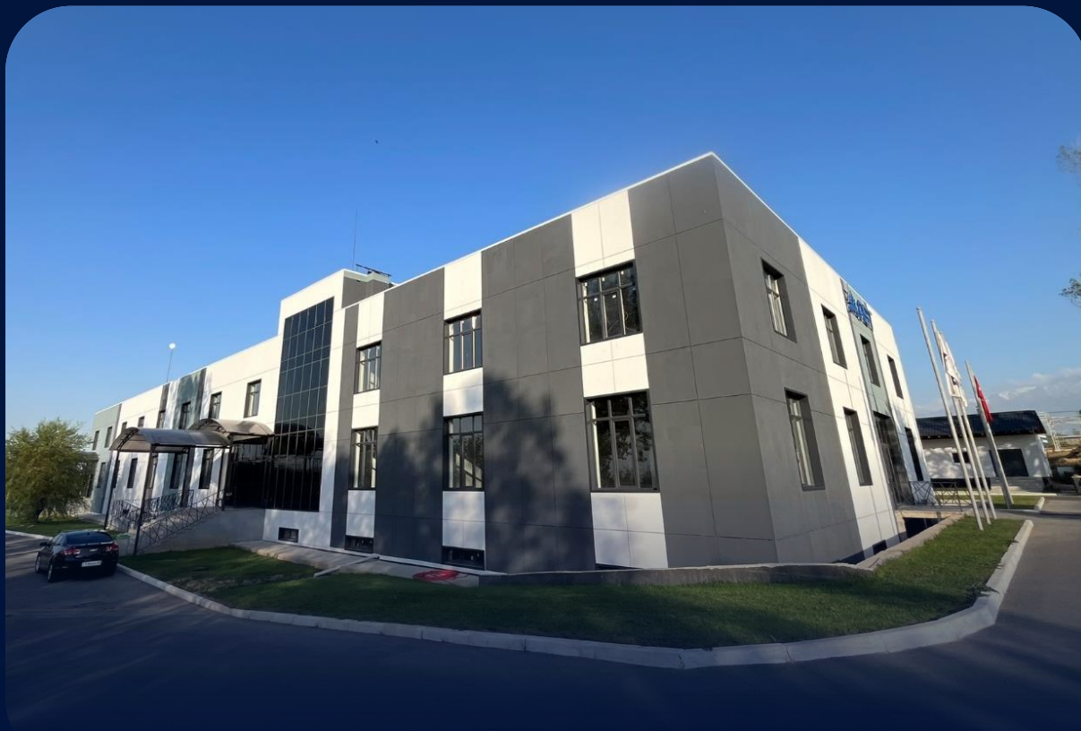
Производственный комплекс в Алматы, Казахстан
